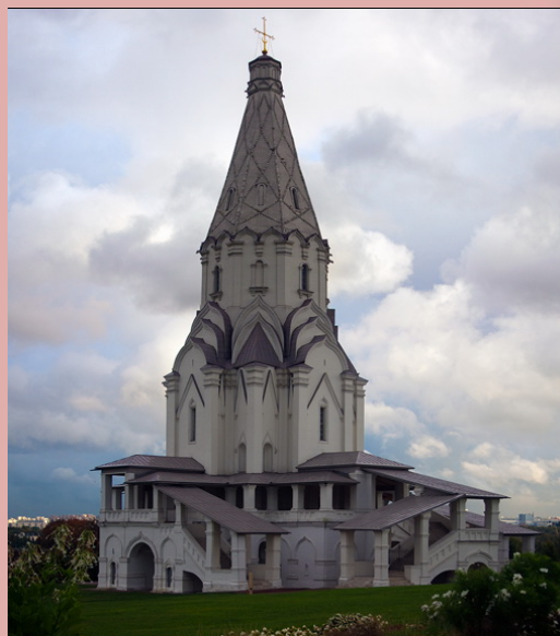
. 199. Церковь Вознесения в Коломенском, архитектор – Петрок Малый, 1532 г.
