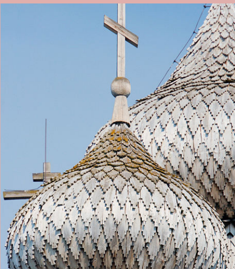
. 24. Лемеховая кровля церкви Преображения Господня, Кижы, 1714 г.
